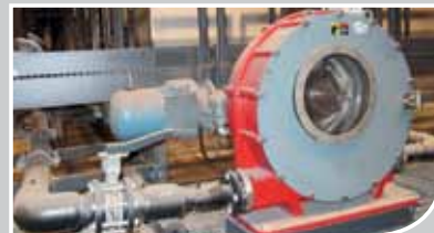
Pesunesteen kiertopumput Talvivaaran kaivoksessa.
