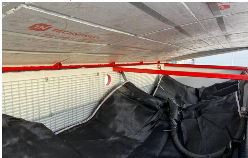
La poche de filtration en géotextile est installée dans le conteneur.
